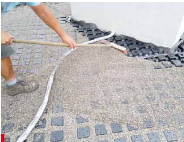
Zastosowany system „Ogród na dachu” z drenażem Floradrain® FD 60
