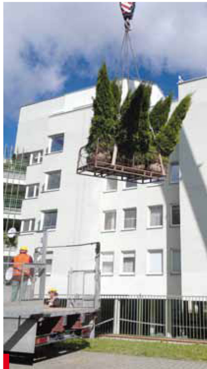
Transport roślin na dach zielony samojezdnym dźwigiem
