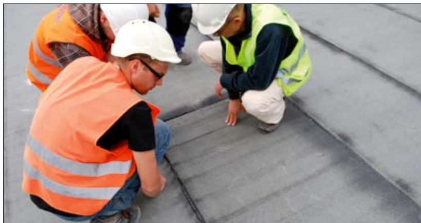
Fot. 4 | Odbiór jakościowy hydroizolacji (autor Natalia Zborowska)
