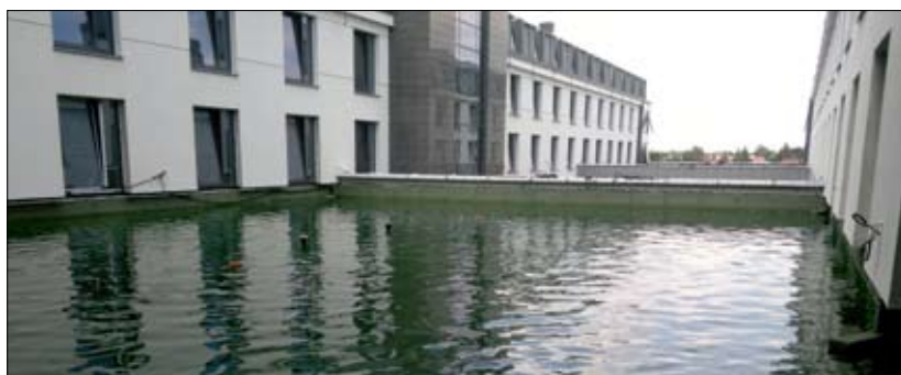
Fot. 5 | Kontrola szczelności hydroizolacji - tzw. „próba wody” (autor Jarema Andrzej Rabiński)
