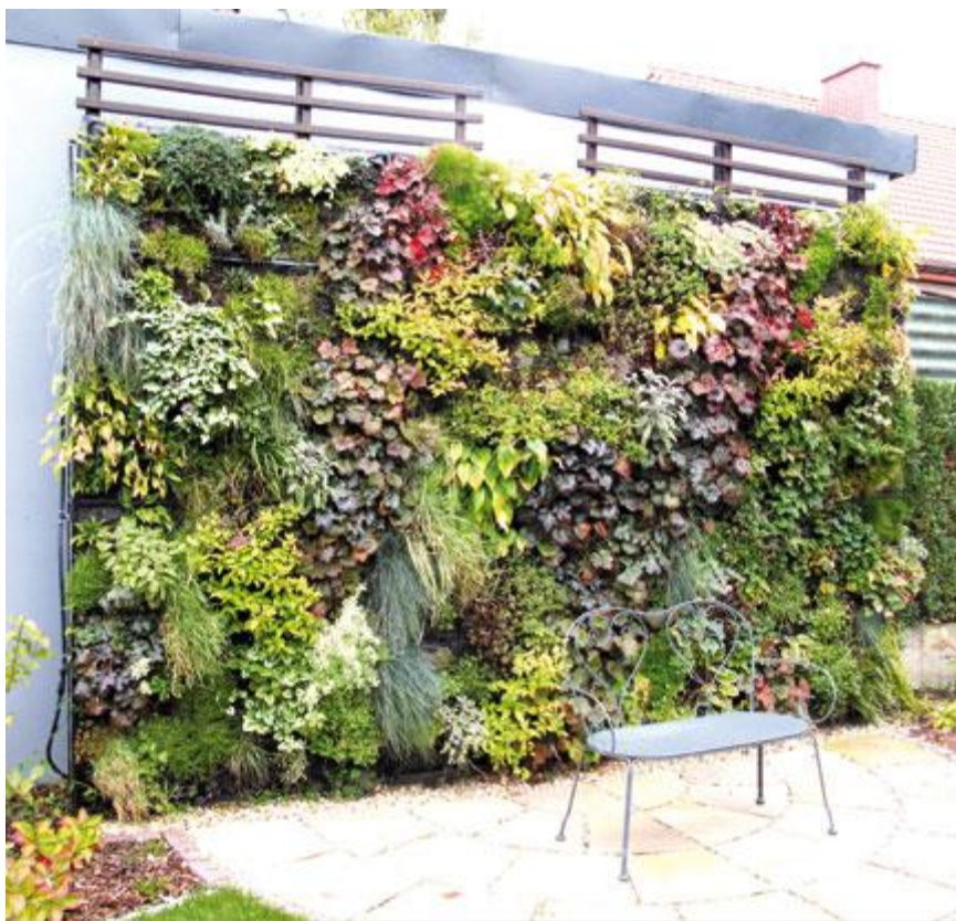
Fot. 6. Zielona ściana w systemie paneli roślinnych z substratem glebowym w sezonie jesiennym (październik 2011)
