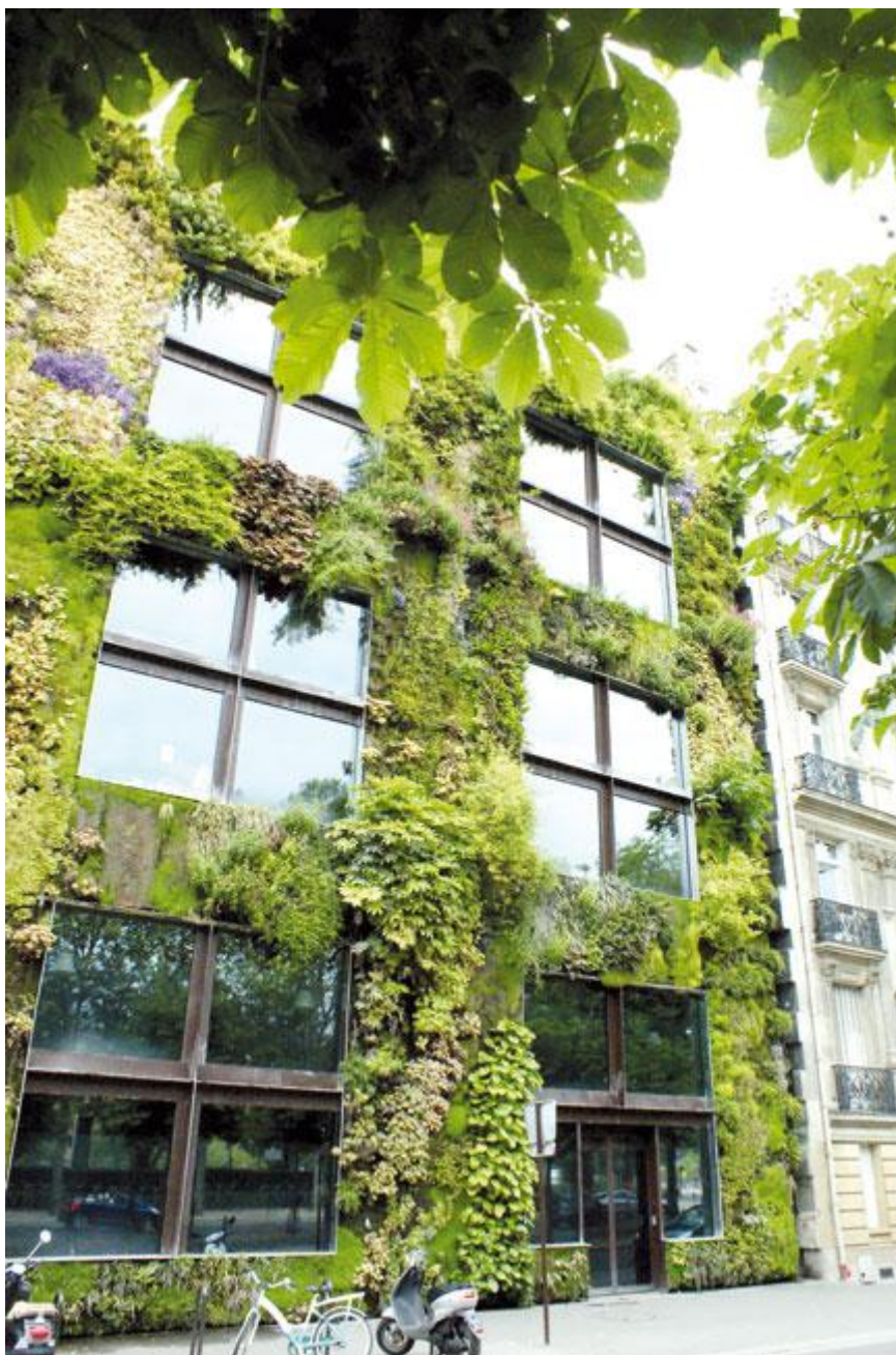
Fot. 4. Zielona ściana na muzeum Quai Branly w Paryżu autorstwa Patricka Blanca w systemie filcu hydroponicznego Fot. Daniel Skarżyński
