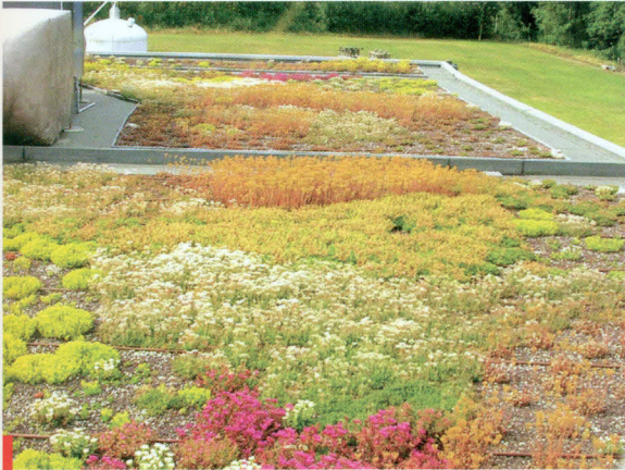
System Tundra — dach ekstensywny. Otrzymywany z sadzonek, ekonomiczny, łatwy w utrzymaniu, trwały. Dobre rozwiązanie dla dachów odwróconych
