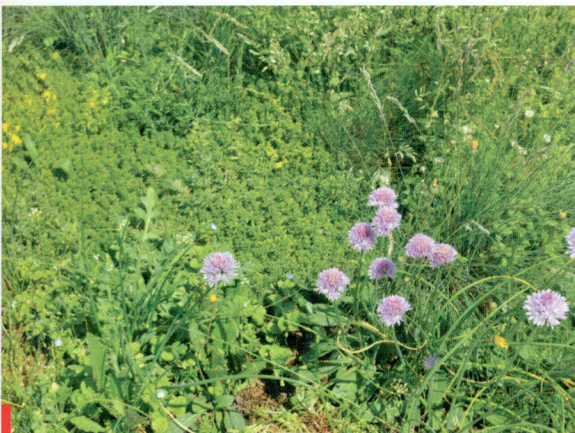
System Pampa — kwietna łąka. Rozwiązanie zbliżone do naturalnego z cechami ekstensywnymi o podwyższonej termoizolacyjności i akustyce
