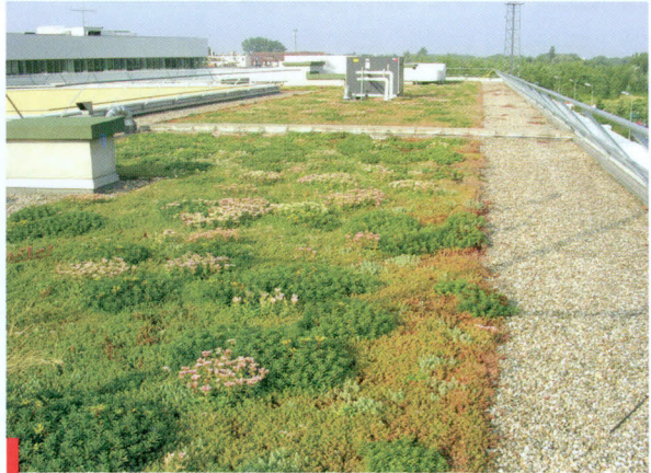
System Tundra Mata. Dach ekstensywny z rolki, łatwy w utrzymaniu i w wykonaniu, gotowe rozwiązanie, bardzo trwałe. Dobre rozwiązanie dla dachów odwróconych
