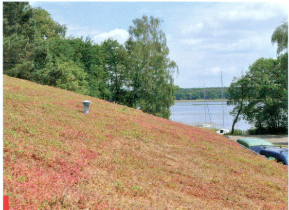
System Tundra Skośny — dach ekstensywny z rolki. Rozwiązanie przeznaczone dla dachów zielonych skośnych, o pochyleniu do 25°
