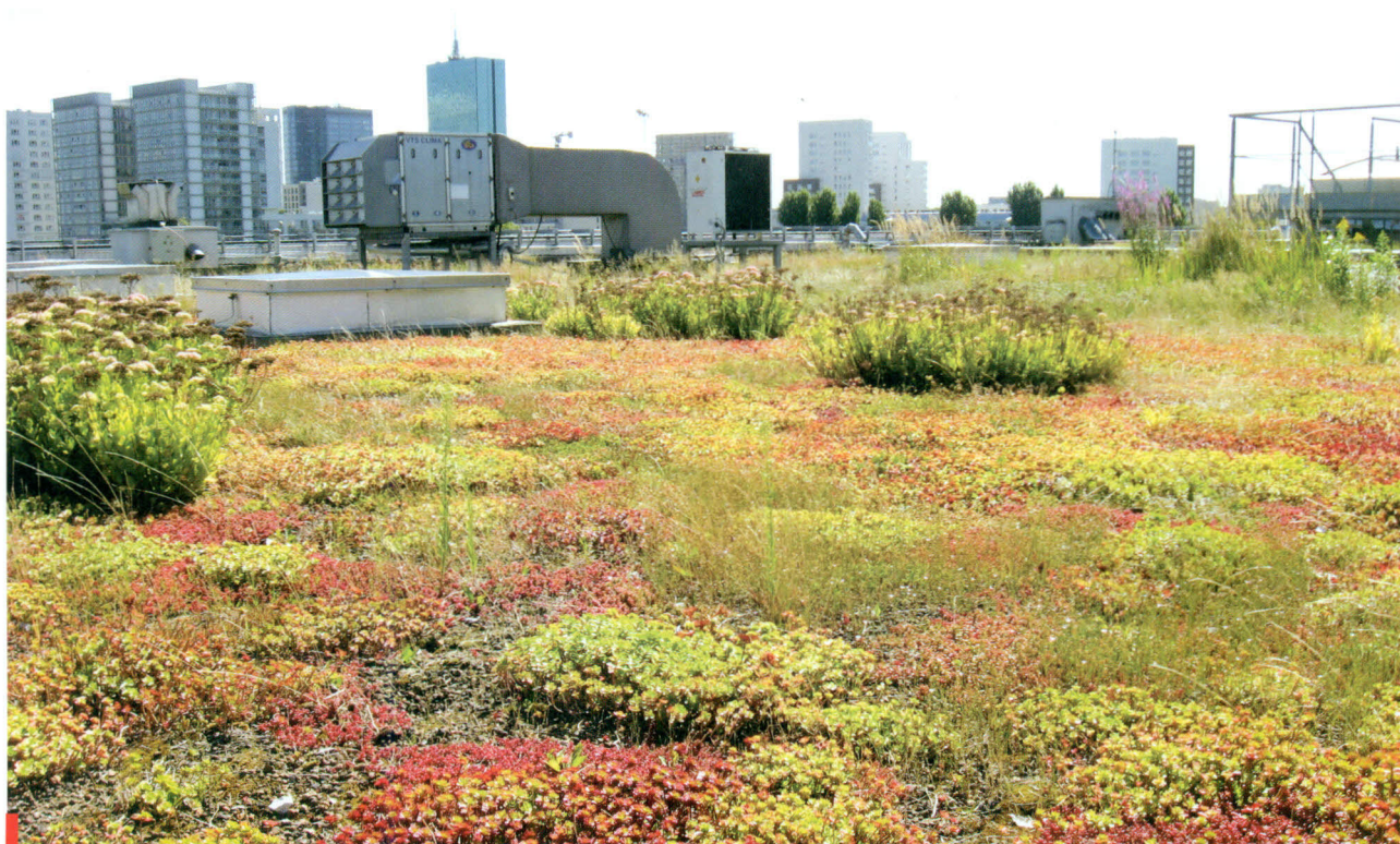
Dach Sopranature w systemie Tundra na Centrum Handlowym Arkadia w Warszawie to największy w Polsce dach zielony
