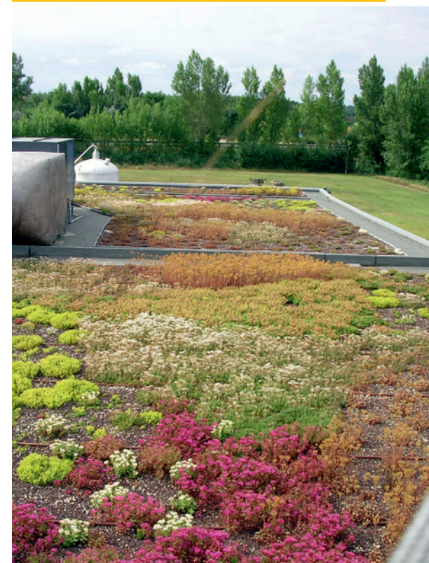
System TUNDRA – dach ekstensywny otrzymywany z sadzonek, ekonomiczny, łatwy w utrzymaniu, trwały, dobre rozwiązanie dla dachów odwrotnych
