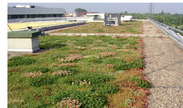
System TUNDRA MATA dach ekstensywny z rolki, łatwy w utrzymaniu i w wykonaniu, gotowe rozwiązanie, bardzo trwałe, dobre rozwiązanie dla dachów odwrotnych
