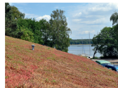
System TUNDRA SKOŚNY – dach ekstensywny z rolki rozwiązanie przeznaczone dla dachów zielonych skośnych do 25°
