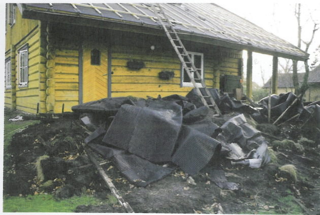
Skutki braku zabezpieczeń przed osuwaniem
