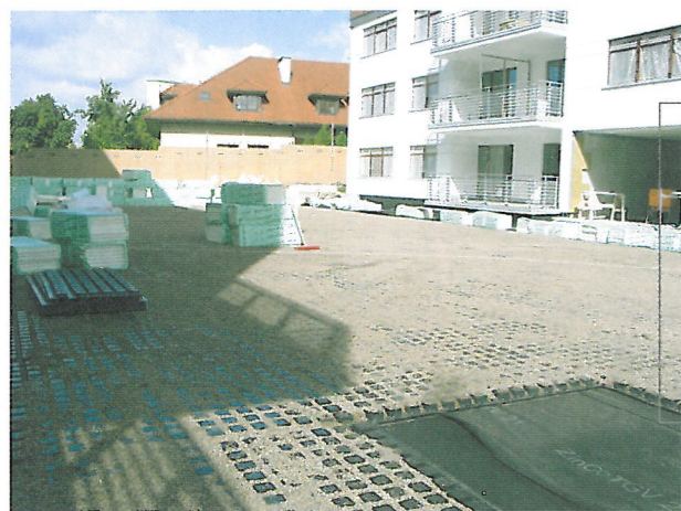
Zielony dach podczas budowy
