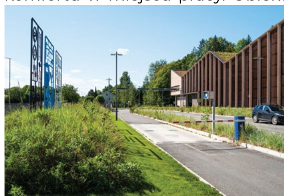
Obiekt unieszkodliwiania odpadów w Smestad
