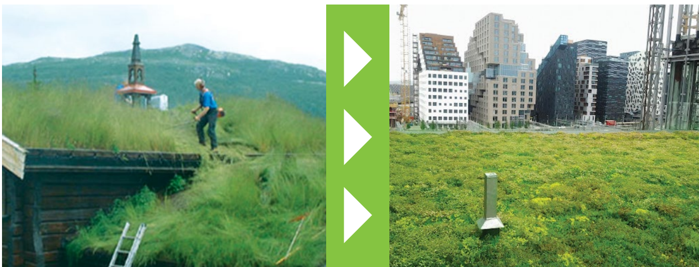
Montaż tradycyjnych dachów darniowych - dachów rozchodnikowych w Dronnings Eufemias gate Oslo Fot. archiwum NFGI
