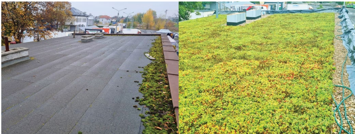
Zielony dach - budynek MOPS przy ul. Lwowskiej 6
