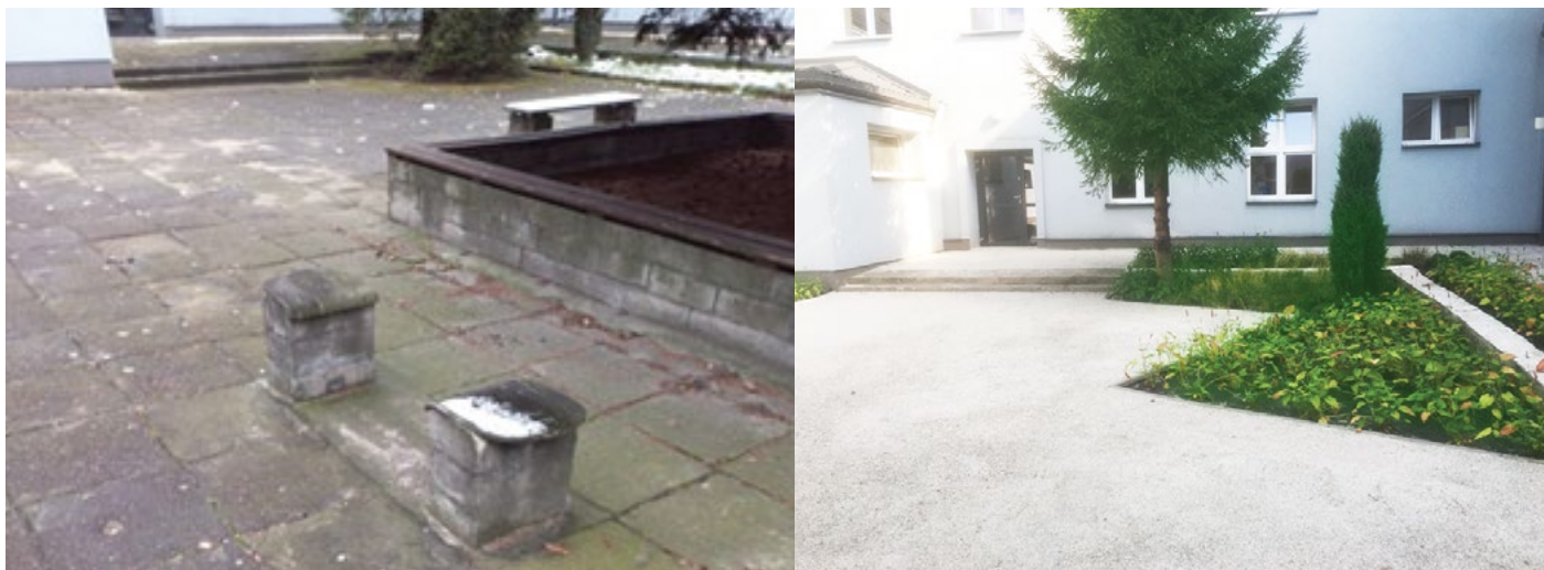
Patio w Szkole Podstawowej nr 3 - przed i po rozszczelnieniu gruntu
