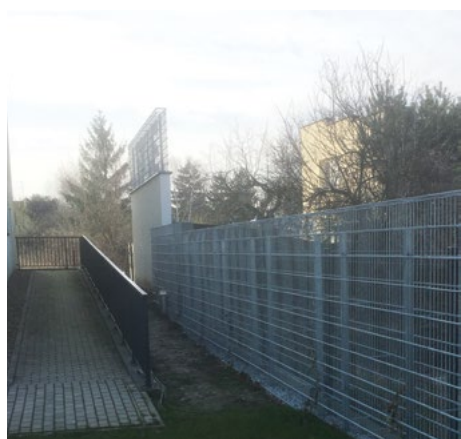
Zielona ściana gabionowa SPZOZ Piastun
