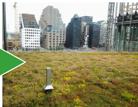
Dachy rozchodnikowe na budynkach przy ulicy Dronnings Eufemias w Oslo
