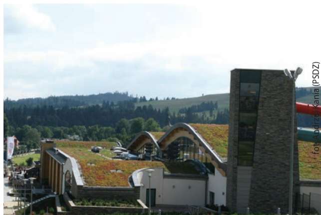
Fot. 2. Dach zielony na obiekcie Term Białka Tatrzańska
