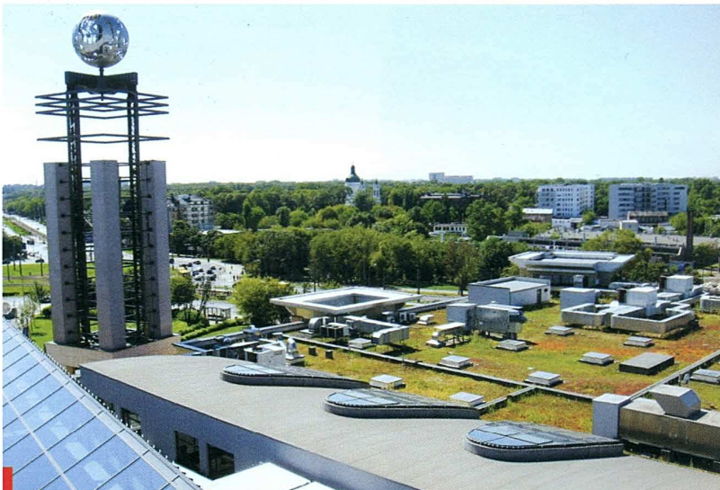
Tak duża liczba urządzeń znajdujących się na dachu wymagała zastosowania materiałów hydroizolacyjnych o nadzwyczajnych właściwościach
