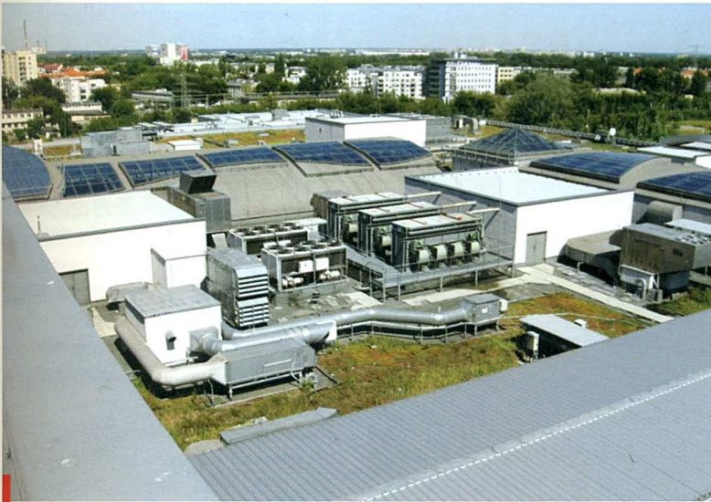
Prace hydroizolacyjne były utrudniane przez dużą liczbę urządzeń technicznych
