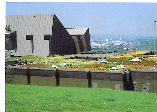
Budynek użyteczności publicznej Esslingen (Niemcy), zbudowany w 1976 r.
